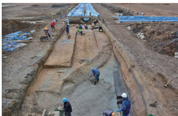
旧河道完掘状況
