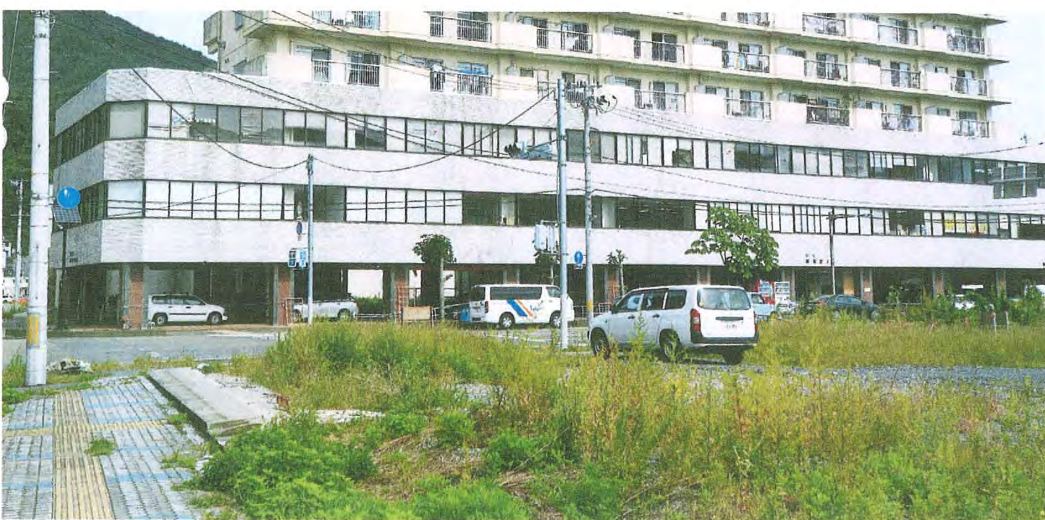
協会の現地事務所が入る市営釜石ビル。2階まで津波が押し寄せた
